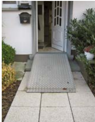
Stufenlos durch eine Rampe
